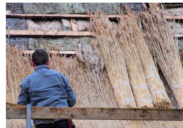
Tækkeren i gang med arbejdet på stuehusets tag.
