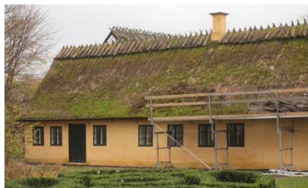
Det gamle, mosbegrøede tag ses nederst til højre og det nylagte herover.
